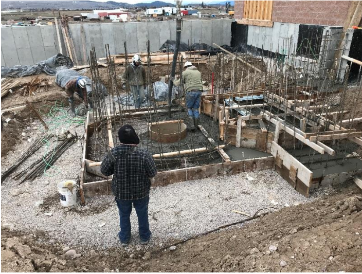
Figure 1 - Grit Chamber Concrete Pour
